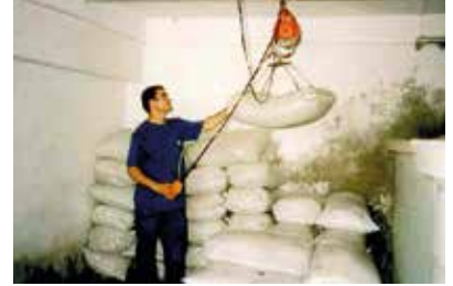
Resim 6. Su Yumuşatıcı için Tuzlama Sistemi
